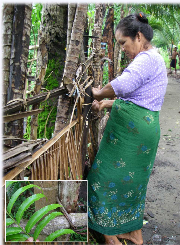
柵を Damin-nwe で留めて修繕する。 エーヤワディーデルタの村(2010.9.4)
